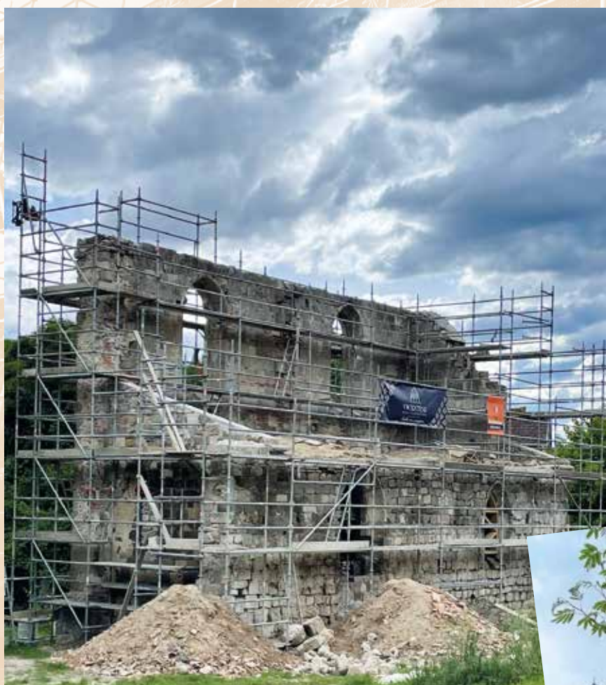
• Vue panoramique du chantier depuis le sud-ouest
